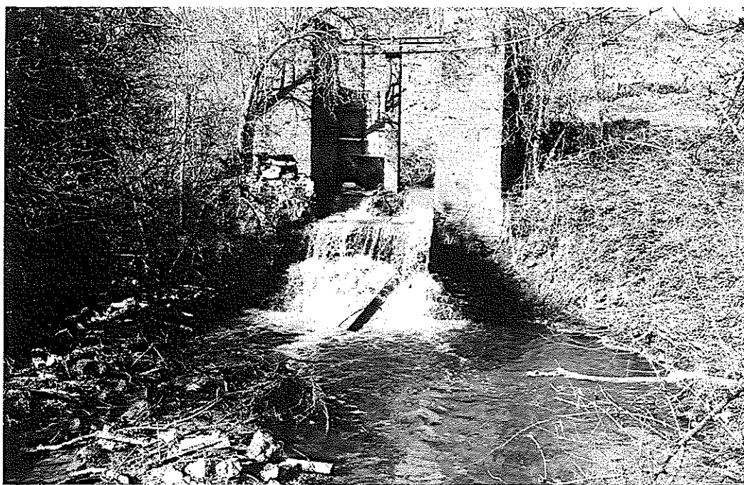
Ce qui subsiste des vannes de la retenue d'eau du « Moulin de la Forge » à Hamme-Mille.
